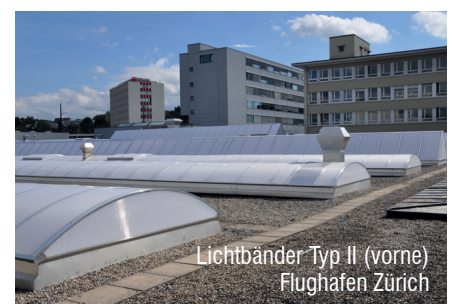
Lichtband Typ II mit opaler Stegplatte
