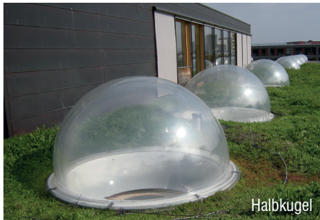
Lichtkuppeln mit RWA-Steuerung, Rolex Learning Center, Lausanne
